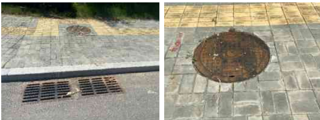
产业大道现状检查井、雨水口照片
