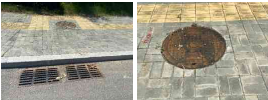
产业大道现状检查井、雨水口照片
