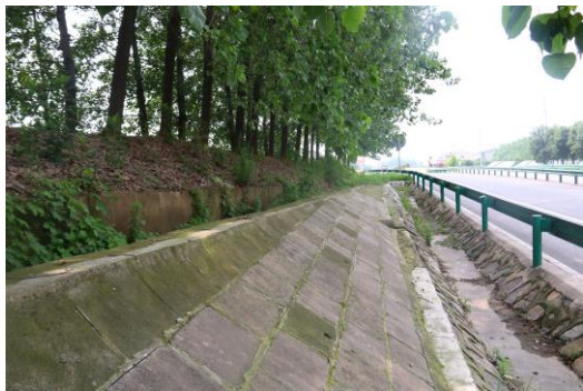
深挖边坡上部植被、下部预制块防护
