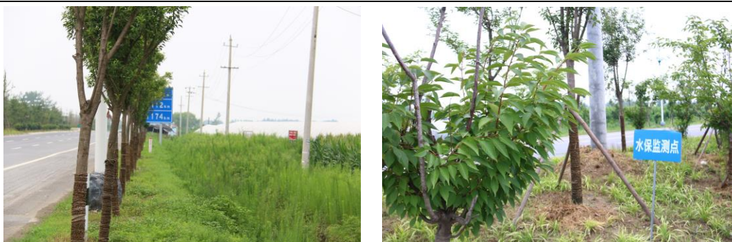
图 1.4 路基边坡植被防护
